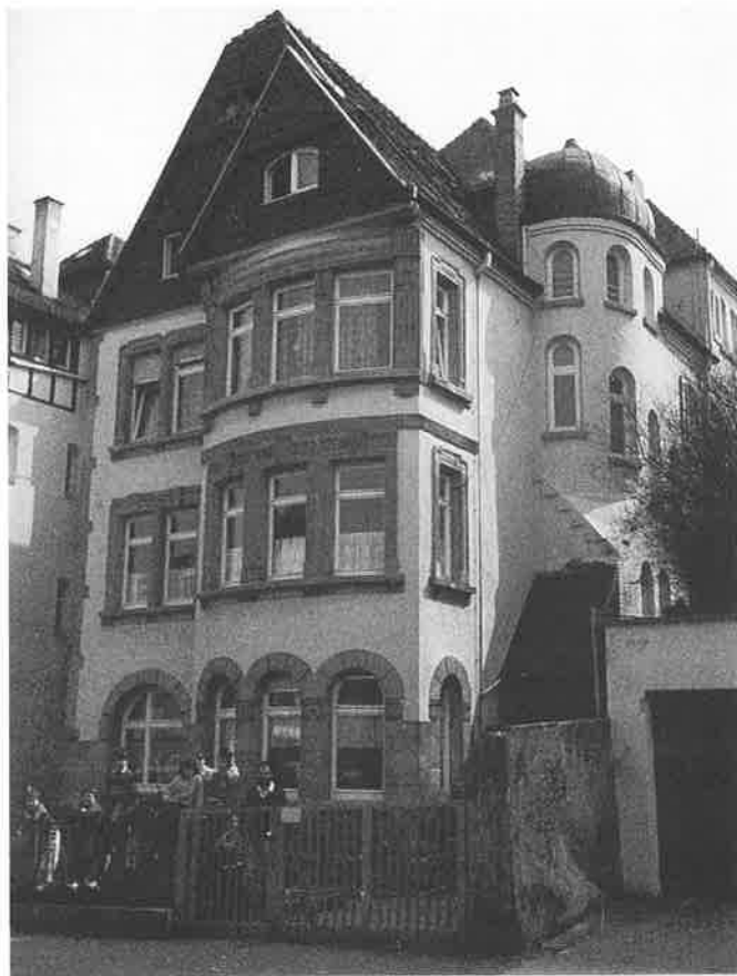
Das 1976 erworbene Gebäude Haußmannstr. 158/158a, das später so genannte TG-Haus ; Aufnahme 1988
